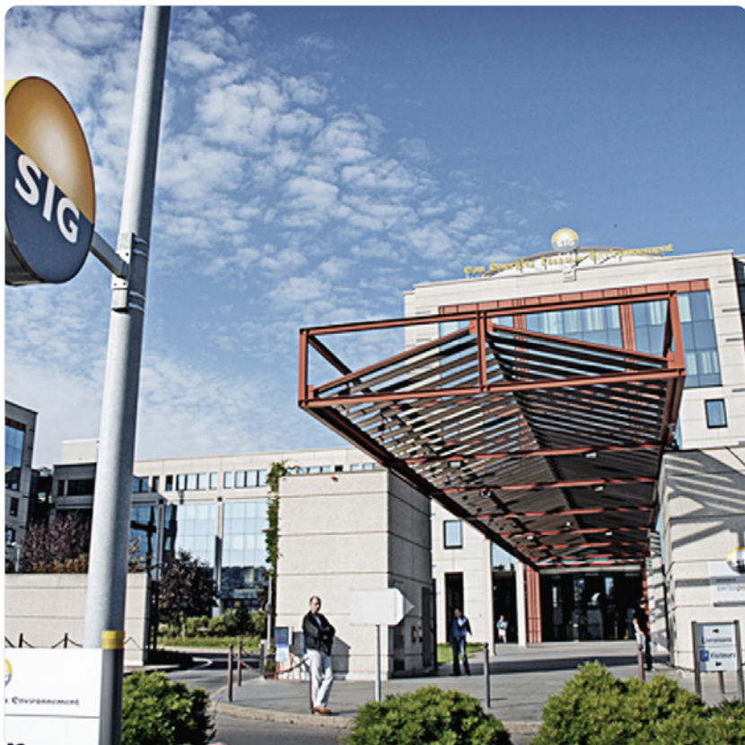
SIG Energieservices | CH
