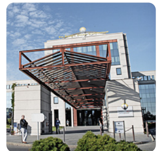
SIG Energieservices | CH
