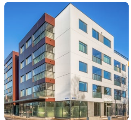
Wohngebäude Sopruse Pst 33 | EST ICS
